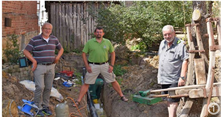
Heinz Heilemann, Ralf Schmitt und Erich Korell (von links) auf der Baustelle im Garten von Hedwig Bittner, die ihren Grund gerne für die Nutzung von 44 Prozent des Müllverbrennungswerks durch Biogasproduzenten im Projekt „Bioenergie“
